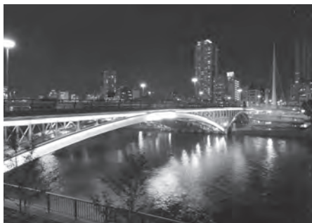
「水都大阪2009」天神橋ライトアップ 灯籠をイメージした光で橋梁のエッジを彩る
