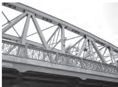
写真2 デティールが美しい震災復興橋(小名木川・西深川橋)
