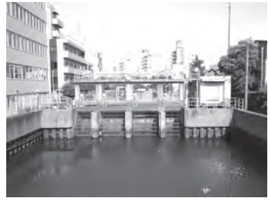
写真5 北十間川樋門
