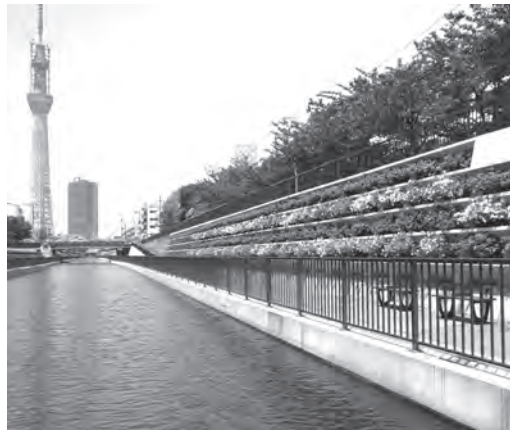
写真4 整備を終えた北十間川畔のテラス
