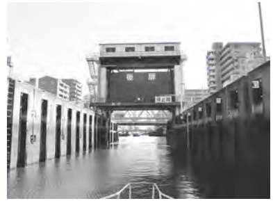
写真3 船の階段・扇橋閘門
