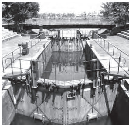
写真6 マイターゲート(観音開き式扉) 閘門の例 富山市・牛島閘門
