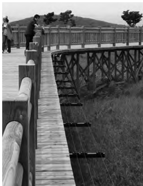
ヒグマと利用者とを物理的に隔離する高架木道
