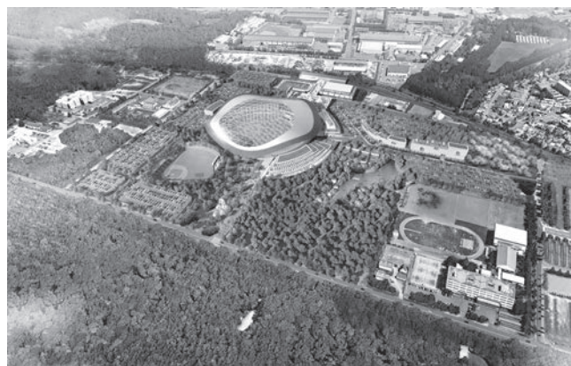
図IV-1-5 北広島市に建設が予定されるボールパーク
