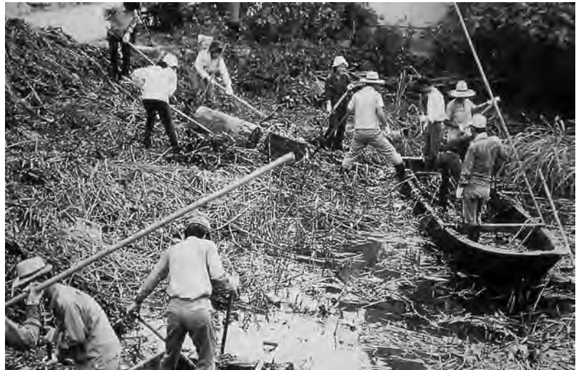
写真2 荒廃した八幡堀の保存再生作業の様子
