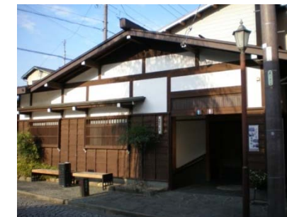
<街並みに配慮した地下歩道入口の外観> (岐阜県飛騨市)
