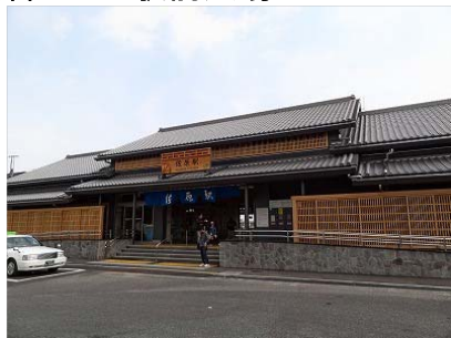
商家町として重伝建地区となっている佐原の玄関口にふさわしい駅舎のデザインが採用されている。(千葉県香取市)
