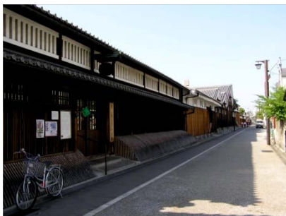
<電線を地中化し街並みに配慮した歩車道> (京都府京都市伏見区)
