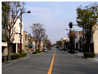
<電線を地中化し植栽を配した車道> (三重県桑名市)
